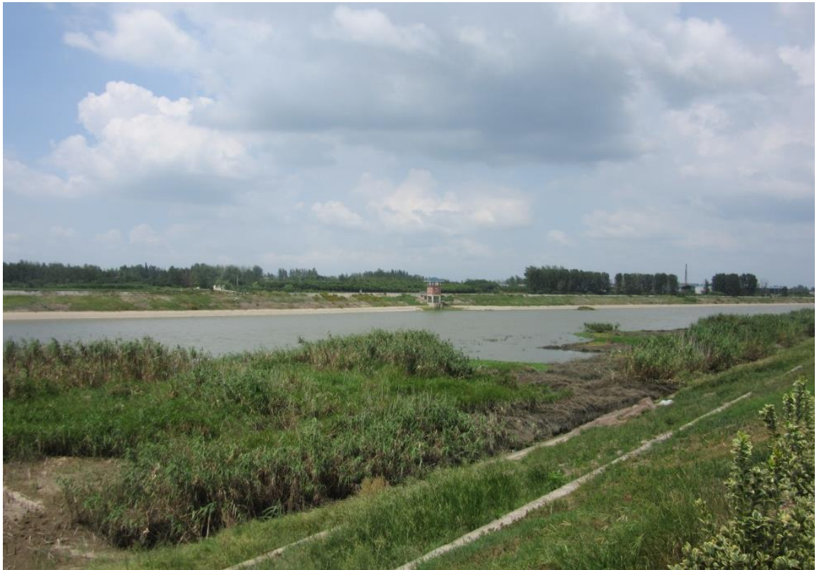
六合段现场情况 1-2
