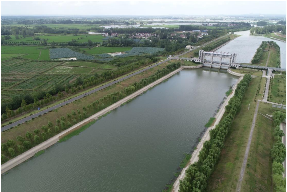
三汊湾现场情况 1-2
